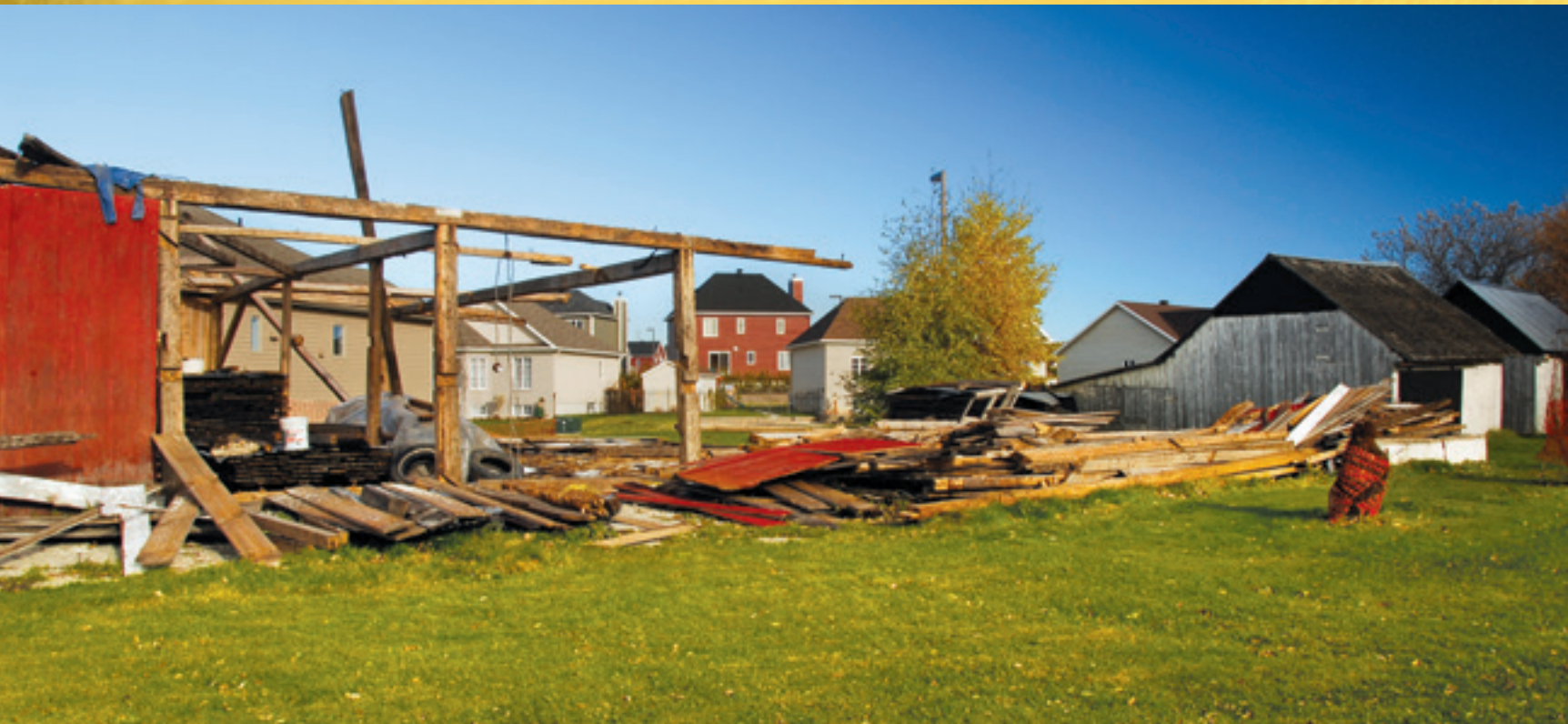
^ Démolition de l'un des derniers bâtiments de ferme du boulevard Saint-Jacques.
